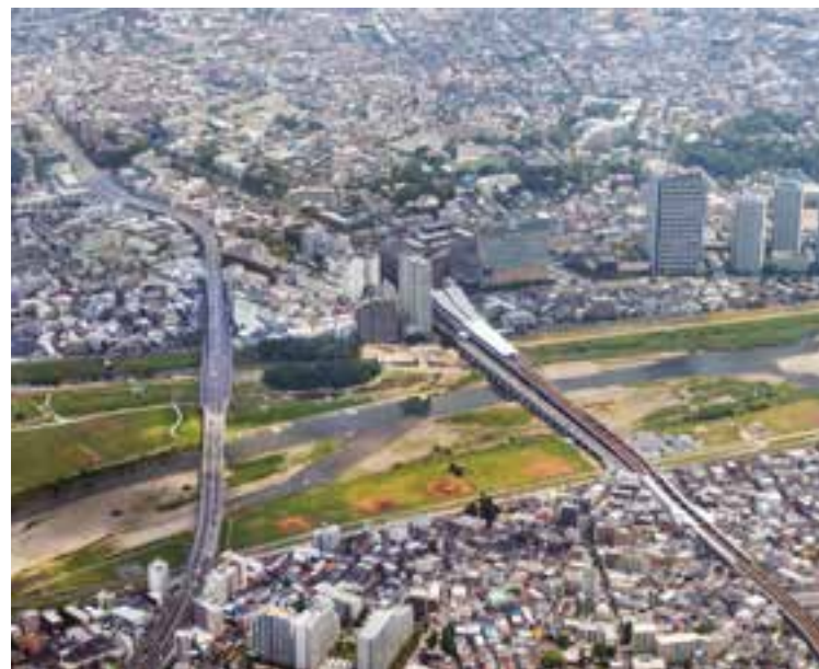
空から見た現在の二子玉川駅周辺。日産厚生会玉川病院、玉川クリニックはここに展開する
