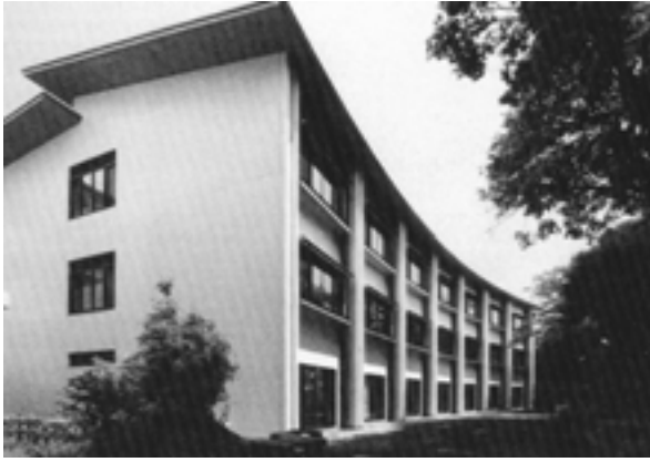
新しくなった 玉川病院南館
