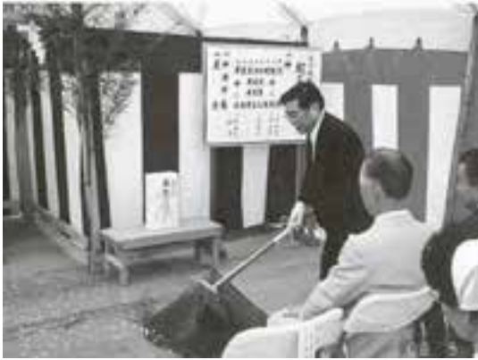
1980年から始まる玉川病院の建て替え工事 (前期工事)の起工式
