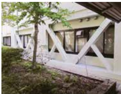
2019(令和元)年に行われた玉川病院での耐震改修工事
