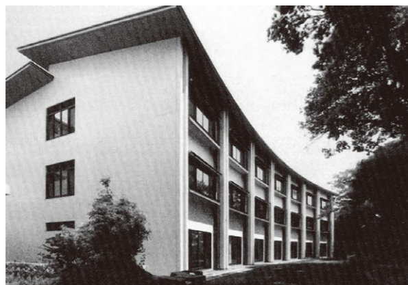
新しくなった 玉川病院南館
