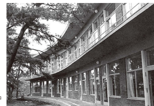
1954(昭和29)年に建てられた第六病棟。鉄筋コンクリート2階建て
